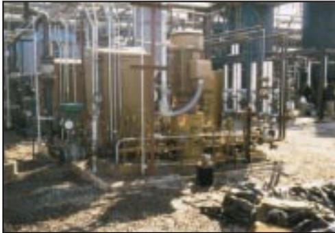
Компрессор типа LMC-331 P с системой контроля пульсаций, звукоизолирующим покрытием корпуса, пультом управления и дистанционной системой смазки, смонтированный на обычных салазках (применение: рицайкл водорода)
