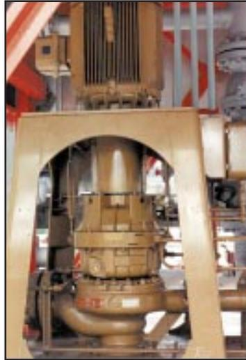
Компрессор типа LMC-313 с вертикальной стойкой двигателя (применение: компрессор регенерационного газа; Южная Америка)
