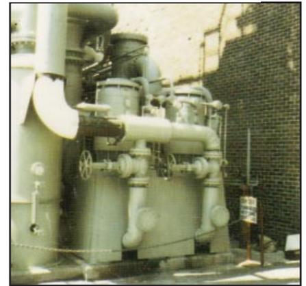
Компрессоры типа LMC-333 с вертикальными стойками (применение: абсорбционная колонна CO<sub>2</sub>)
